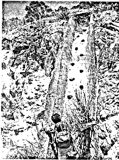
圖一：坡面上的排水溝
