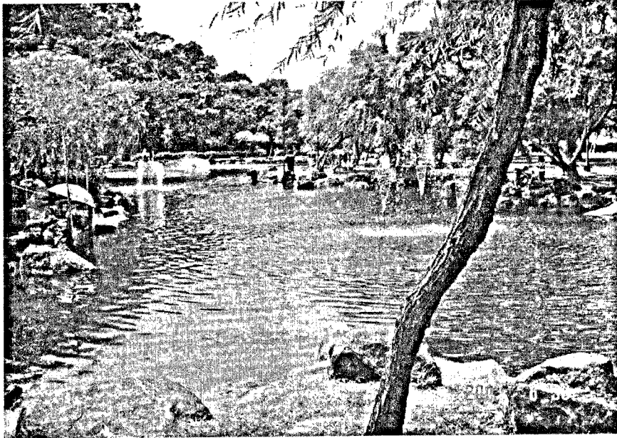
圖六：貴子坑的滯洪池
