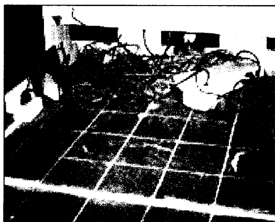
圖 6-4 ①電線上有 PVC 壓條蓋住凸出地板上，壓條一旦脫落較易絆倒人
