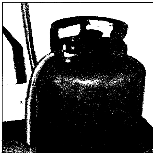
圖 6-9 ①瓦斯筒加裝防爆器。 ②瓦期管是雙層軟管，持久而不易破裂。(三重國中)
